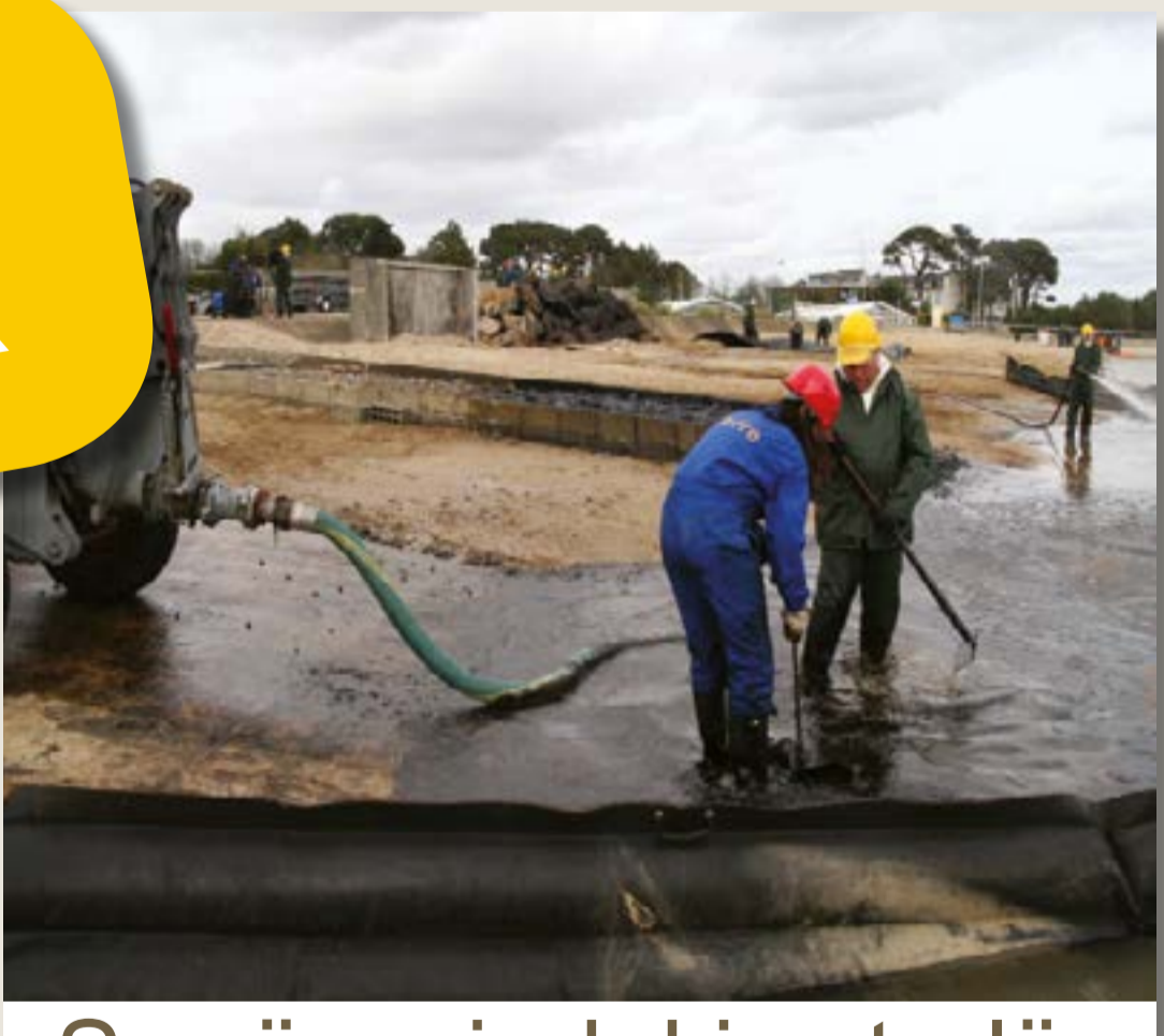
Su yüzeyindeki petrolün pompayla çekilmesi
