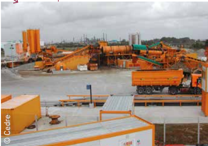
Planta de tratamiento construida para el lavado de sedimentos durante el vertido del Erika
