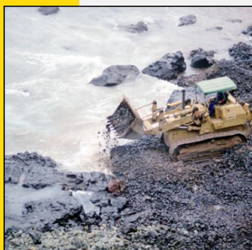
Limpieza surf: Empujar los sedimentos contaminados a la playa en la zona de surf (media marea) Recuperar el petróleo liberado (redes)
